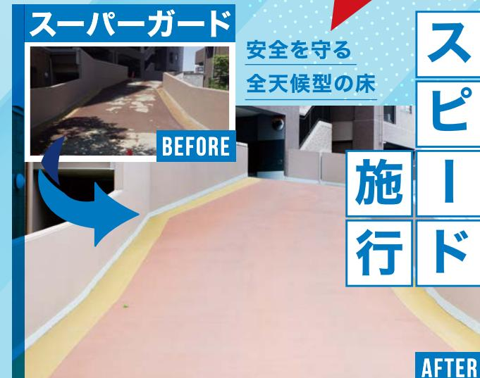
約24時間で使用可能な速硬性と、雨でも安心の防滑性能を兼ね備えた無機系薄塗り床材。駐車場やスロープなど、広範囲の改修工事に適しています。
